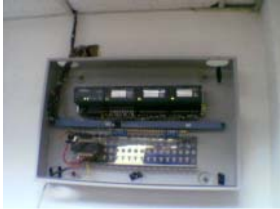
NI 温度湿度控制模块: 温度模块 (FP-TC-120) 和湿度模块(FP-AI-111)
